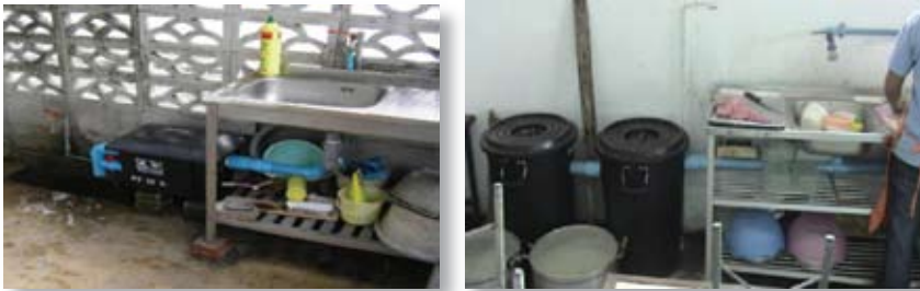
ภาพที่ 2.11 การติดตั้งถังหรือบ่อชักโครกในครัวเรือน
