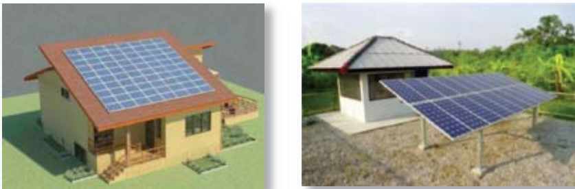
ภาพที่ 3.15 การติดตั้งแผงโซลาร์เซลล์บนหลังคาบ้าน (ซ้าย) และติดตั้งบริเวณบ้าน (ขวา)
